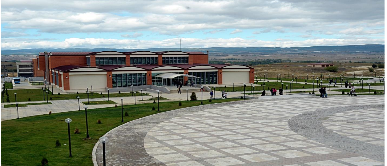
Resim 1- Kastamonu Üniversitesi Merkez Kafeterya Görünüm.
